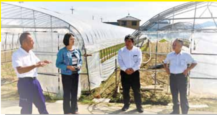
▲ビニールハウスの被害を調査する藤井県議と草津市議団
